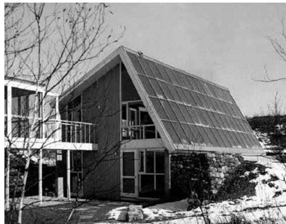
Figur 3: Ansicht des 1958 für den Massenbau geplanten Solarhauses des «Massachusetts Institute of Technology» (MIT) in Lexington, Mass. – Schon 1958 wurde in den USA ein Solarhaus gebaut, das im Winter etwa zur Hälfte mit Solarenergie geheizt wurde. Nach dem Kollaps der Energiepreise wurde die weitere Subventionierung aufgegeben.
